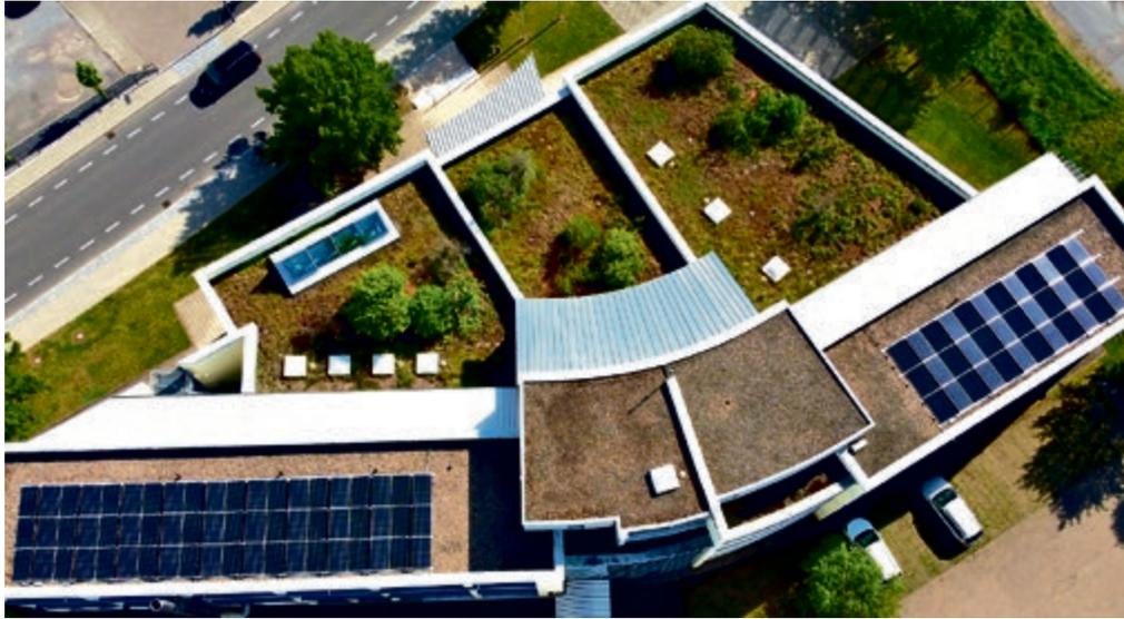
Photovoltaikanlage mit 96 Solarmodulen auf dem Dach des Kopfbaus des Technologie- und Gründerzentrums Ilmenau. Foto: TGZI
